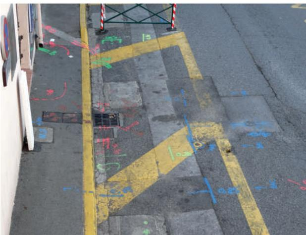
Dans le cadre du diagnostic « Réseaux », la société Rezo chargée de ces travaux a matérialisé les réseaux existants dans l'emprise de l'étude afin de les géolocaliser sur les plans.
