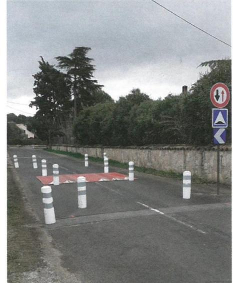
7. Traverse de l'Enclos : pose de pavés le long des murs et voirie en enrobé avec chaînette en pavés
