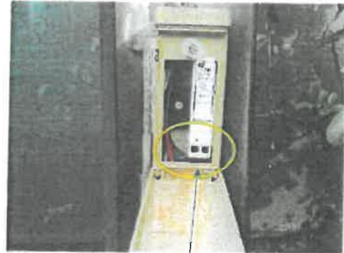
Branchement entre le neutre et la phase Attention il faudra faire une VAT avant le branchement
