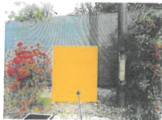
Une borne sera installée pour accueillir le coffret+Mlan+Batterie Slat
