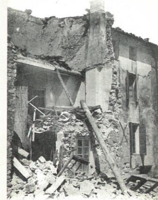
TREMBLEMENT DE TERRE des (B.-des-Rh.) 21 Juin 1909 LAMBESC - Maison en Ruines. I. C.
